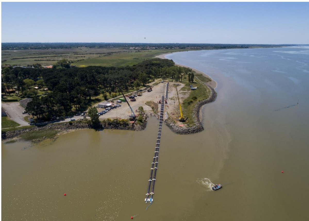
Installation en mai 2020 des fourreaux destinés à protéger les futurs câbles sous-marins
